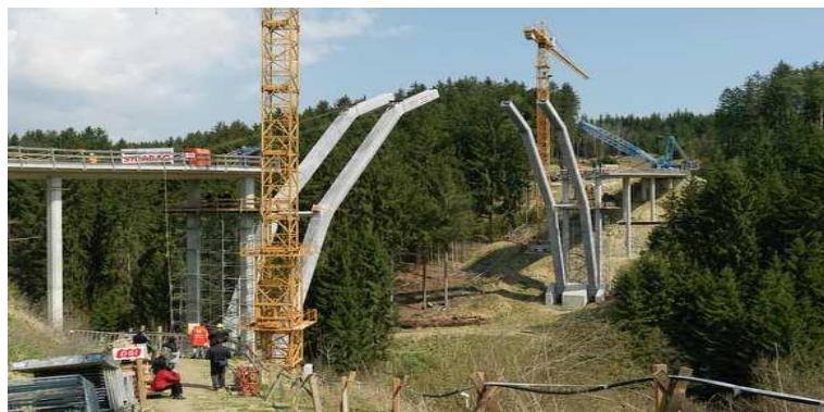
Figura 17 Wild Bridge en construcción. (García, 2013)
