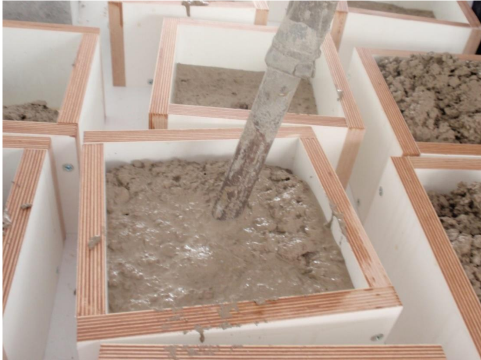
Figura 4. Vibrado del hormigón
