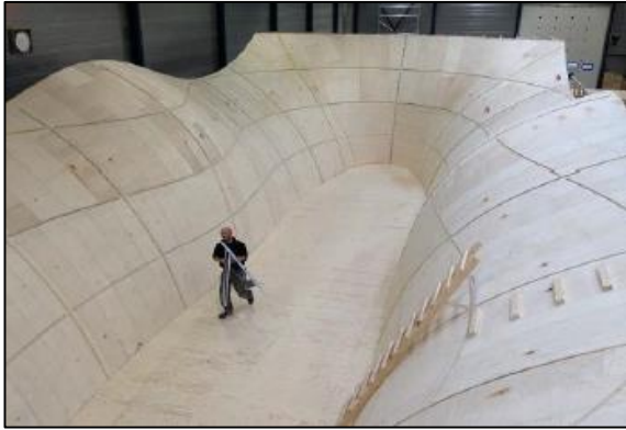
Fig. 21. Encofrado de madera a una cara para piezas de doble curvatura.
