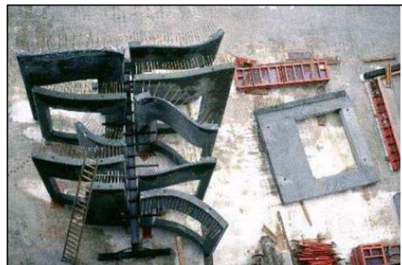
Fig. 4. Elementos prefabricados Der Neue Zollhof, Düsseldorf (Alemania)
