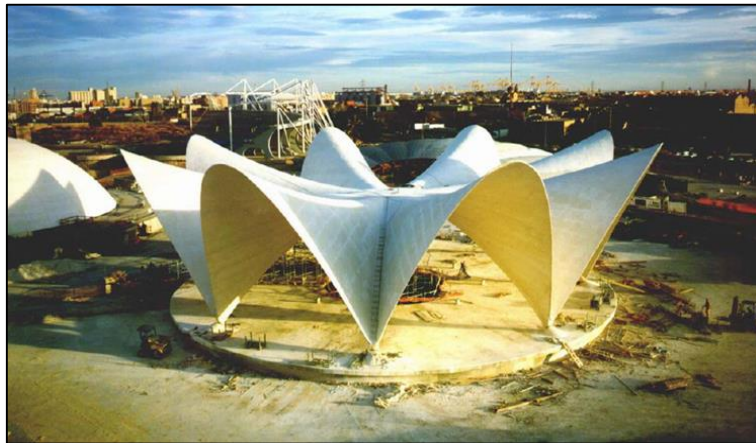
Fig. 5. Construcción de la cubierta del parque del oceanográfico (Valencia) [4]
