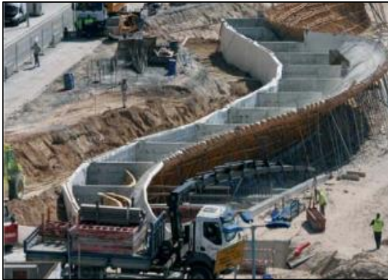
Fig. 8. Encofrado, Paseo marítimo de Playa de Poniente, Benidorm (Alicante)
