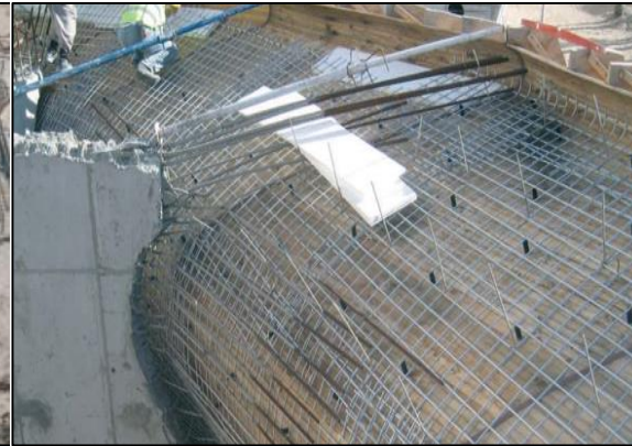
Fig. 9. Detalle de encofrado, Paseo marítimo de Playa de Poniente, Benidorm (Alicante)
