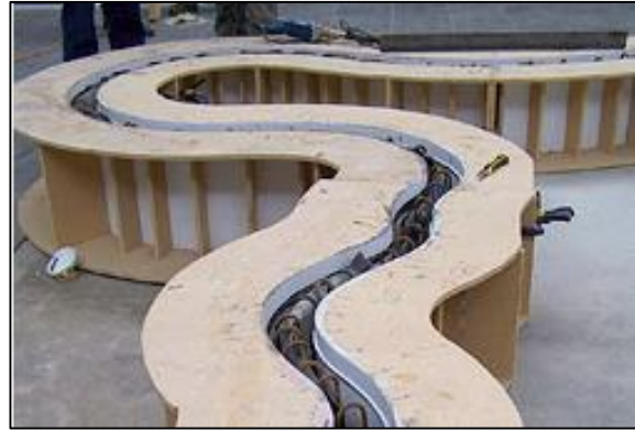
Fig. 22. Encofrado a dos caras.
