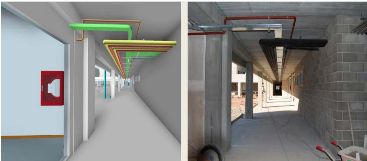
Fig. 3. Diseño y puesta en obra de instalaciones vistas
