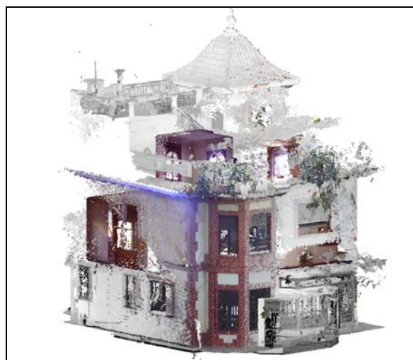
Imagen 1. Nube de puntos de vivienda unifamiliar. Fuente: A. Soria
