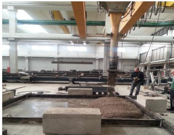
*Figura 29. Hormigonado de placa*
