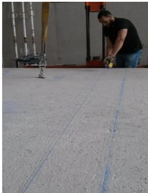
*Figura 51. Proceso de marcado de puntos de apoyo*
