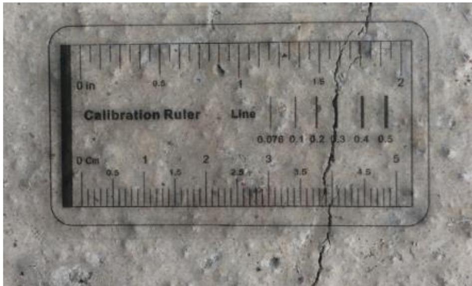
*Figura 74. Fisura en lateral de placa de HRFA*
