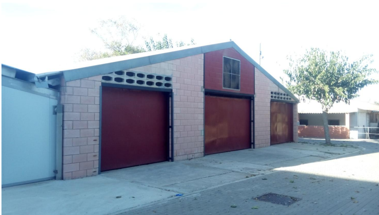
Imagen nº 3.- Fachada principal de la nave.
