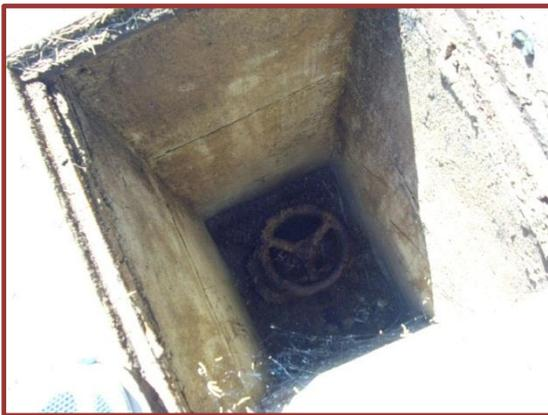
Figura 4.6. Arqueta y válvula de seccionamiento en conducción principal
