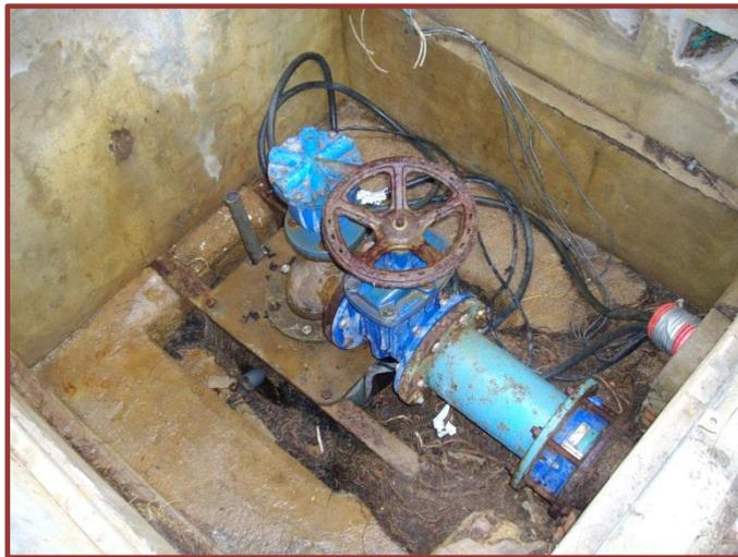
Figura 4.3. Instalación a la salida del pozo
