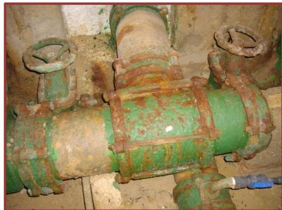
Figura 4.7. Válvulas en cámara de llaves.
