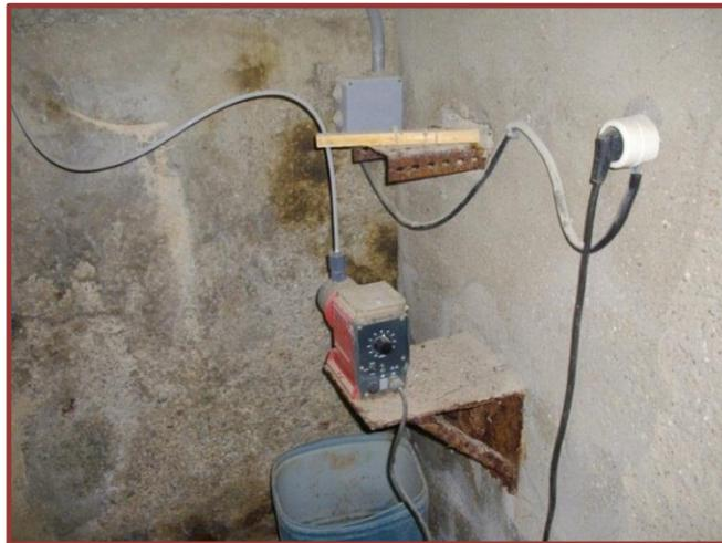
Figura 4.8. Bomba dosificadora de cloro
