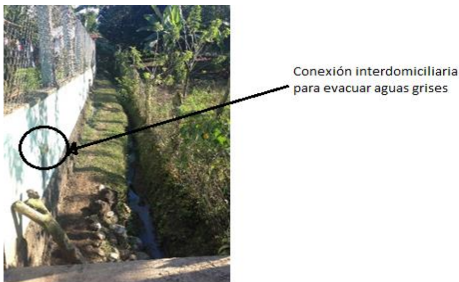
Figura 7. Tipo de conexiones interdomiciliarias instaladas actualmente en la ciudad. (Elaboración propia)
