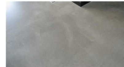
Pavimento autonivelante cementoso acabado epoxi gris sombra sin junta (PLANTA BAJA)
