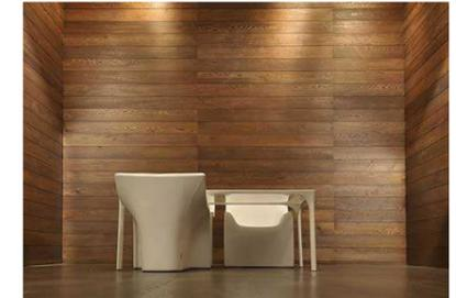
se emplean paneles de madera de wengué en la parte inferior combinado con un revestimiento de microcemento de color blanco roto. Por detrás de los paneles se coloca una luminaria fluorescente que creará una banda de iluminación difusa
