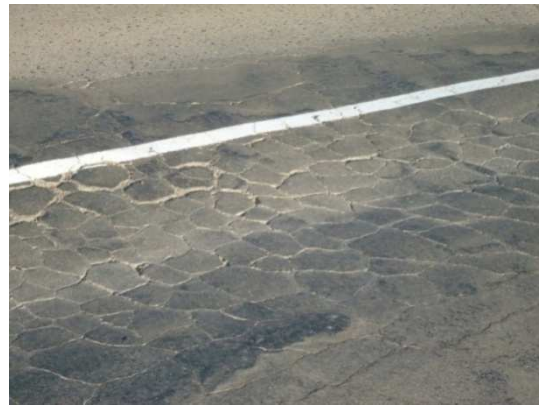
Figuras 73 y 74. Ejemplo deformación (rodera) y Ejemplo rotura (piel de cocodrilo).
