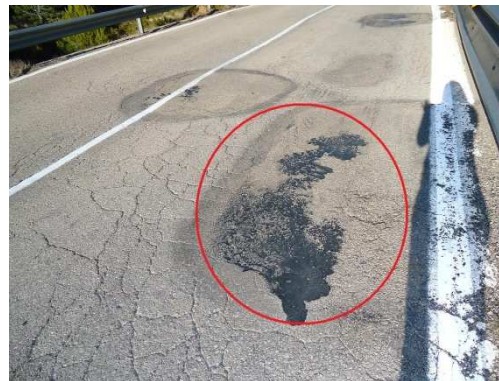
Figuras 75 y 76. Ejemplo desprendimientos (árido pulimentado) y (firme brillante).
