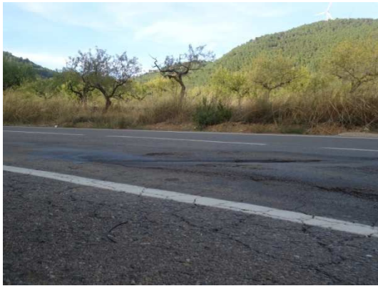
Figuras 73 y 74. Ejemplo deformación (rodera) y Ejemplo rotura (piel de cocodrilo).
