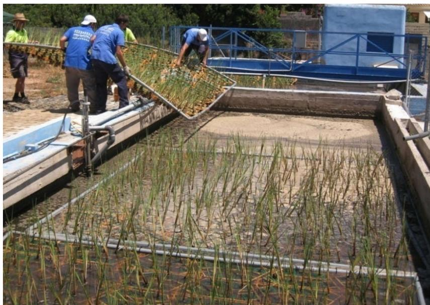
Figura 13: Instalación del FMF en el reactor biológico (fuente Urb. “Los Monasterios” 2012)
