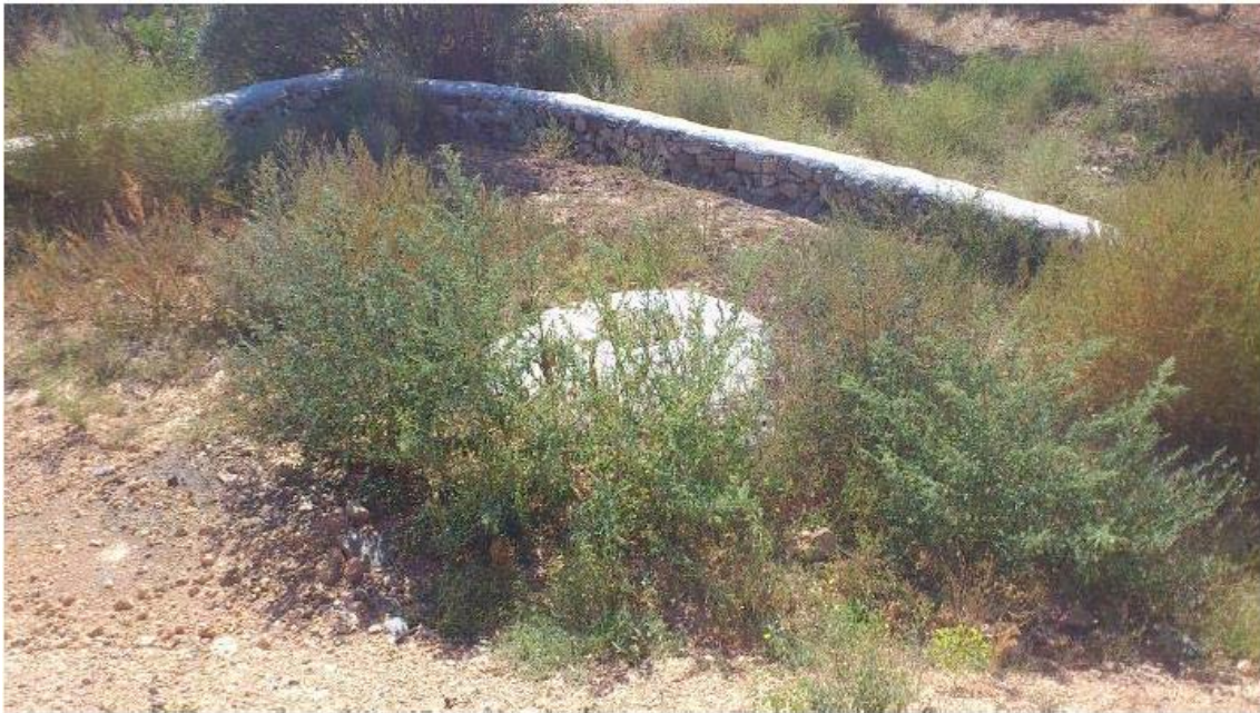
Figura 11. Detalle de la tapa de acceso al depósito, una vez enterrado.
