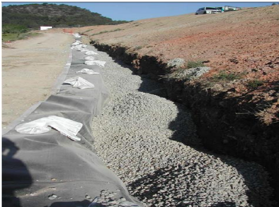
Figura 8. Zanja para reconducir el lixiviado.
