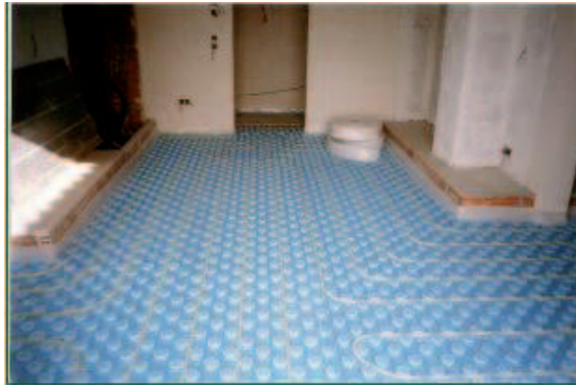
Instalación suelo radiante
