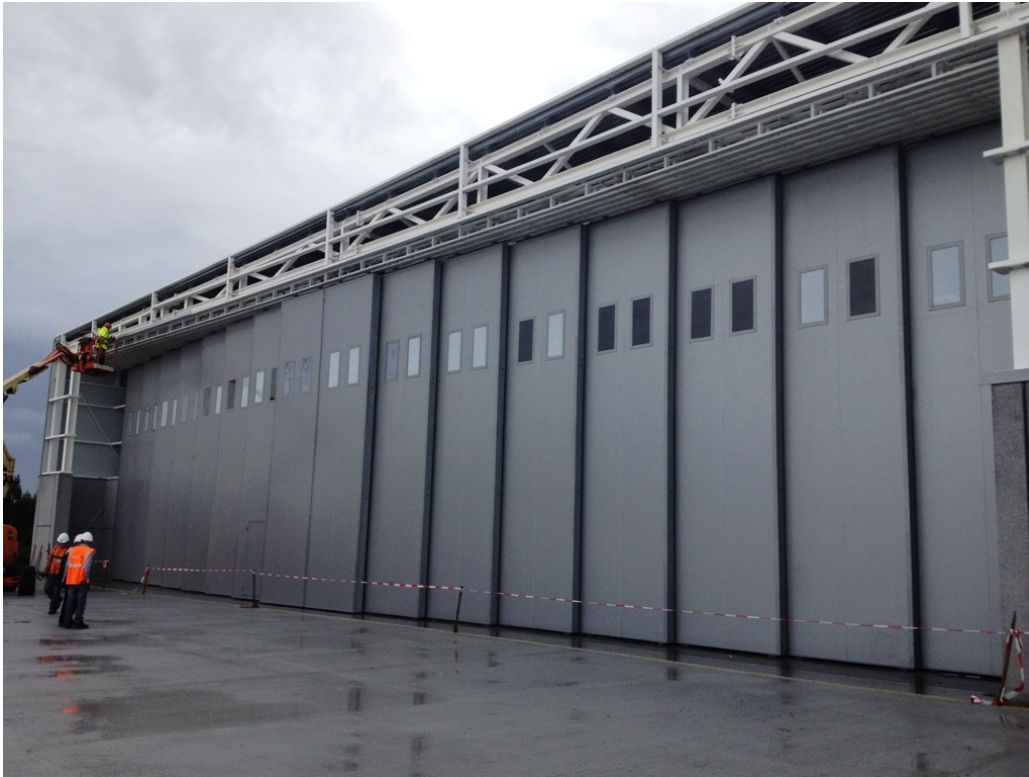
Figura 5.4.5: Ejemplo de la puerta de un hangar plegable tipo acordeón
