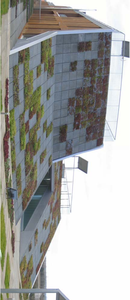
Cubierta realizada con el Sistema TF de Intemper con losa Filtrón, junto con zonas ajardinadas.
