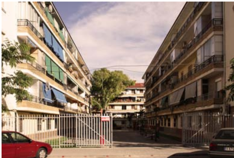
Fig 1. Vista del estado actual de una de las calles que linda con el boulevard principal.
