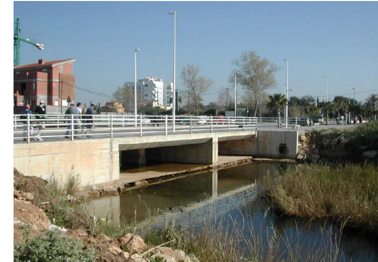
Figura 2. Puente antiguo sobre la Rambla de Alcalá.
