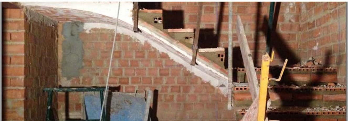
Ilustración 27 Escalera de revoltón en construcción. aktua.com febrero 2014
