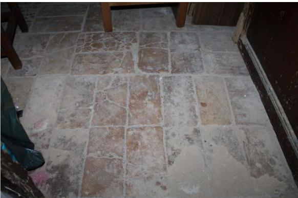
Ilustración 20 Pavimento de la planta baja sobre el terreno compacto. Fuente Propia. 2016
