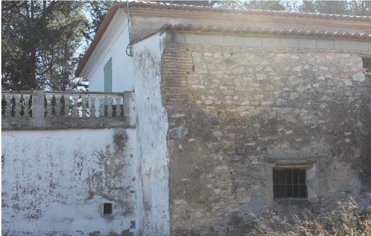
Ilustración 21 Muro de mampostería con y sin cal, pilar de ladrillo macizo. Fuente Propia. 2016
