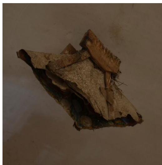
Fig. 93, Clave de bóveda plegada por el peso de la tela
