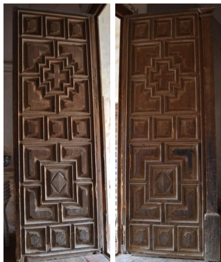
Fig. 97 y 98, puerta de acceso a la nave central.
