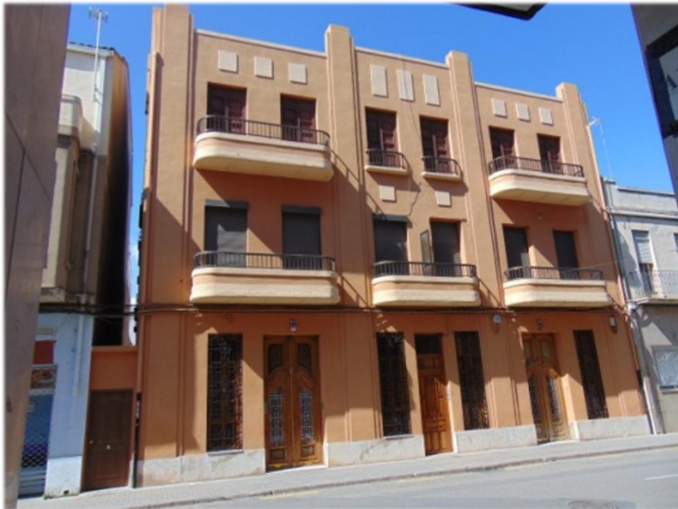
Figura 10. Fachada Principal 2016, Fuente Propia
