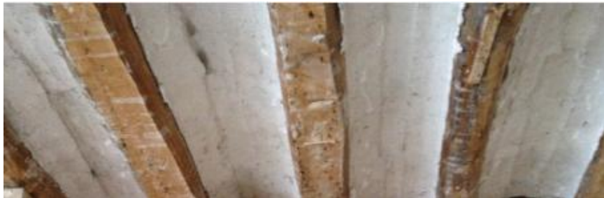
Ilustración 17 Detalle de forjado existente de revoltón acabado. Fuente Propia
