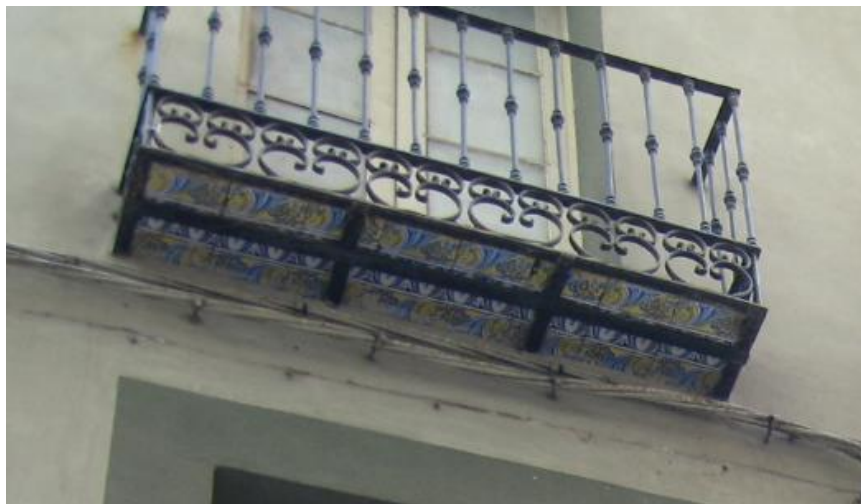
Ilustración 21 Fondo de balcón cerámico Fuente propia
