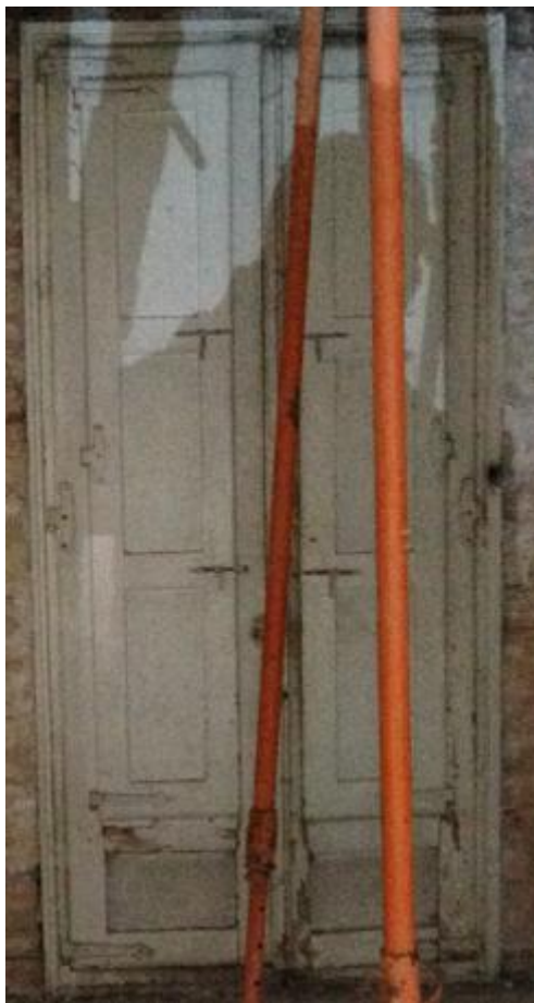
Ilustración 19 Puerta Balconera desde el interior Fuente Propia
