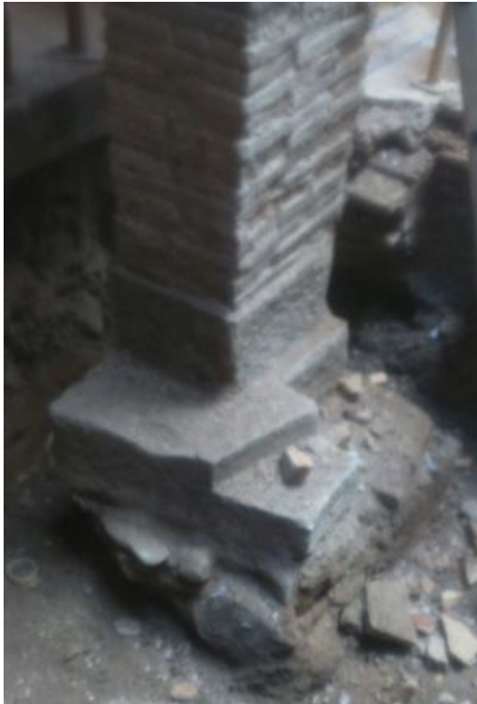
Ilustración 16 Detalle de zapata de pilar Fuente propia
