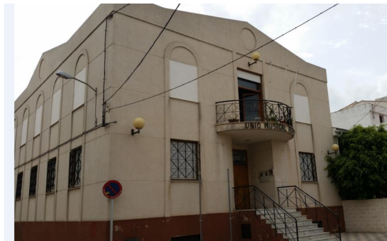
Figura 128. Revestimiento: Fachada Principal.
