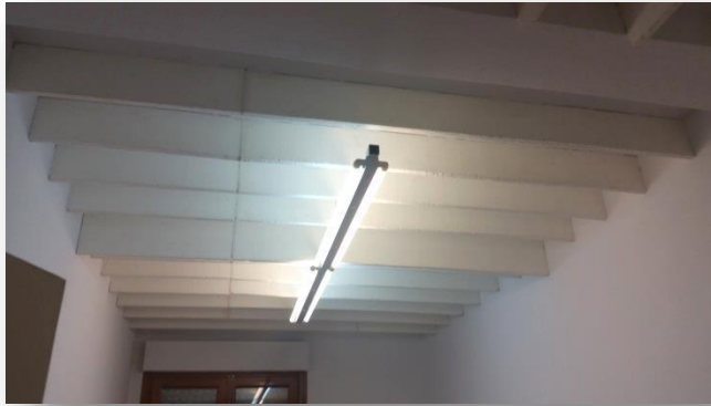
Figura 28. Aislamiento cara inferior forjado Aula 1(PB).
