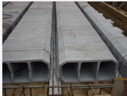
Figura 22 .Forjado Bovedilla Hormigón. Google.
