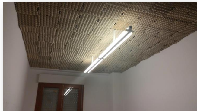
Figura 27, Aislamiento cara inferior forjado PB (Aula 2) .
