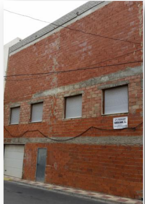
Figura 5. Fachada Lateral-Ampliación de la escuela.2013. Figura 6. Fachada Lateral-Ampliación escuela.2015.
