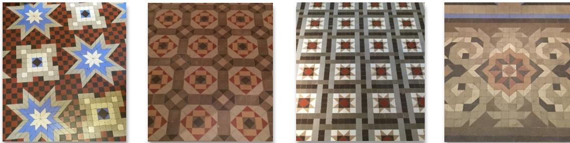
Figura 58. Pavimentos de gres porcelánico de Nolla existentes en planta baja. 2015. Fuente propia.
