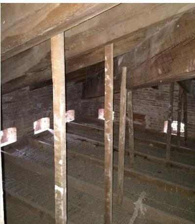
El falso techo está resuelto mediante la disposición de rastreles que apoyan directamente sobre los pilares y el muro de carga y que se encuentran atirantados con listones de madera a la estructura de la cubierta. La cara inferior de los rastreles se encuentra cubierta con un entramado de cañizo sobre el que se enlucce la cara vista de éste con mortero de cal o yeso.
