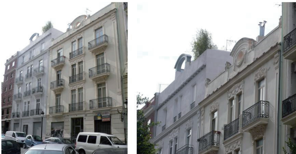
Figura 19. Frente de fachada de los edificios situados en los números 20 y 22 de la Calle Sueca, donde se lleva a cabo la sobreelevación de la última planta sobre la misma línea de fachada, sin acometer el retanqueo que permitiría apreciar la fachada del edificio en su estado original..
