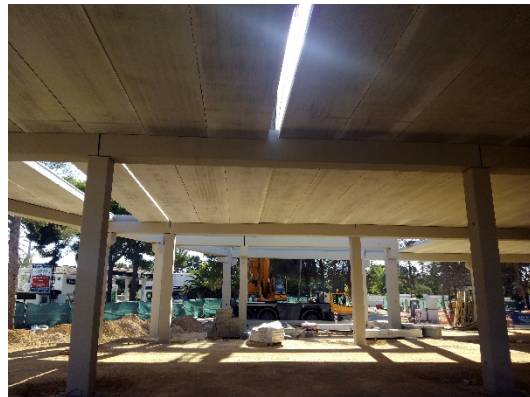
Figura 2.4.5 Pórticos con losa alveolar
