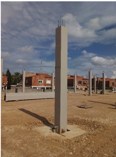
Figura 2.4.3 Pilar empotrado en cimentación
