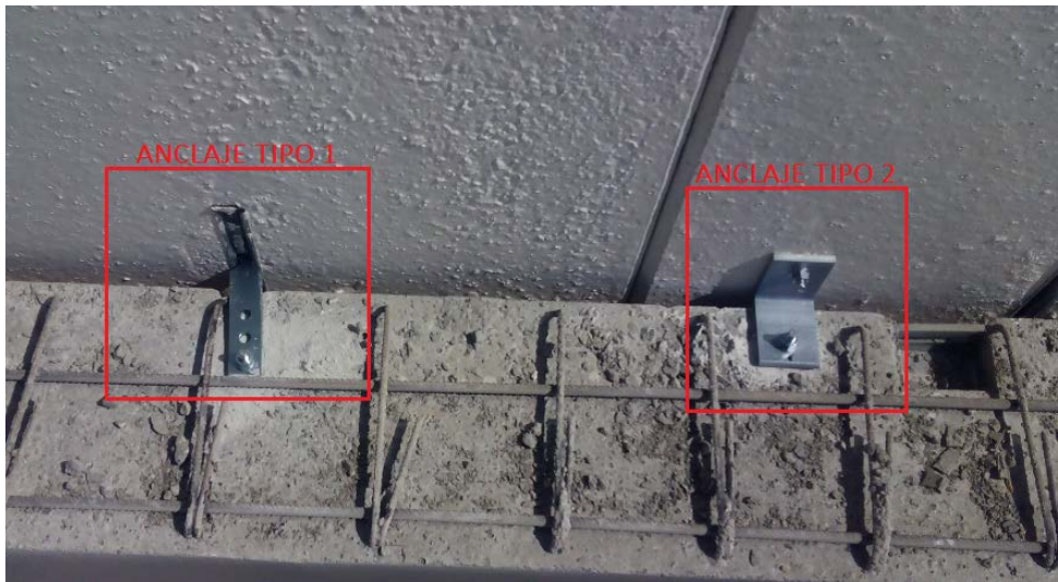
1. ANCLAJES TIPO 1 Y TIPO 2
