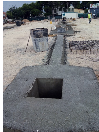
Figura 2.4.2 Cimentación-viga de atado
