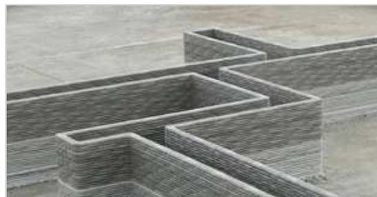
Imagen 12: Extrusión del elemento. Fuente: [42].
