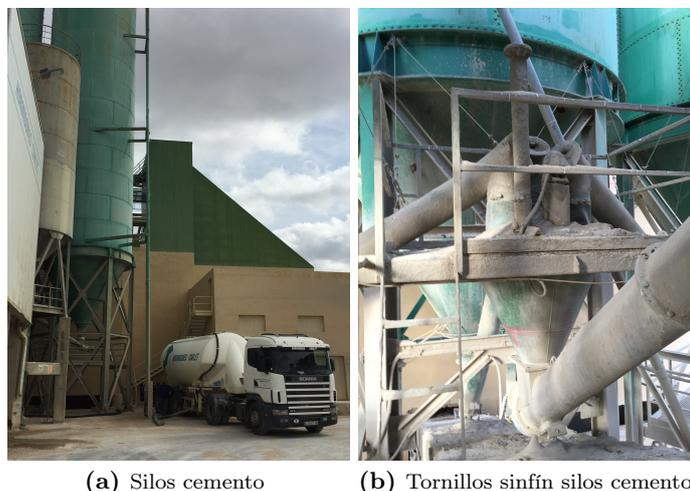
Figura 3.11: Elementos de almacenamiento y dosificación de cemento.
