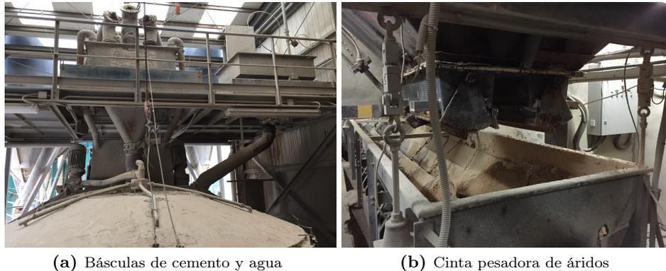
**Figura 3.12:** Elementos de dosificación en planta.
