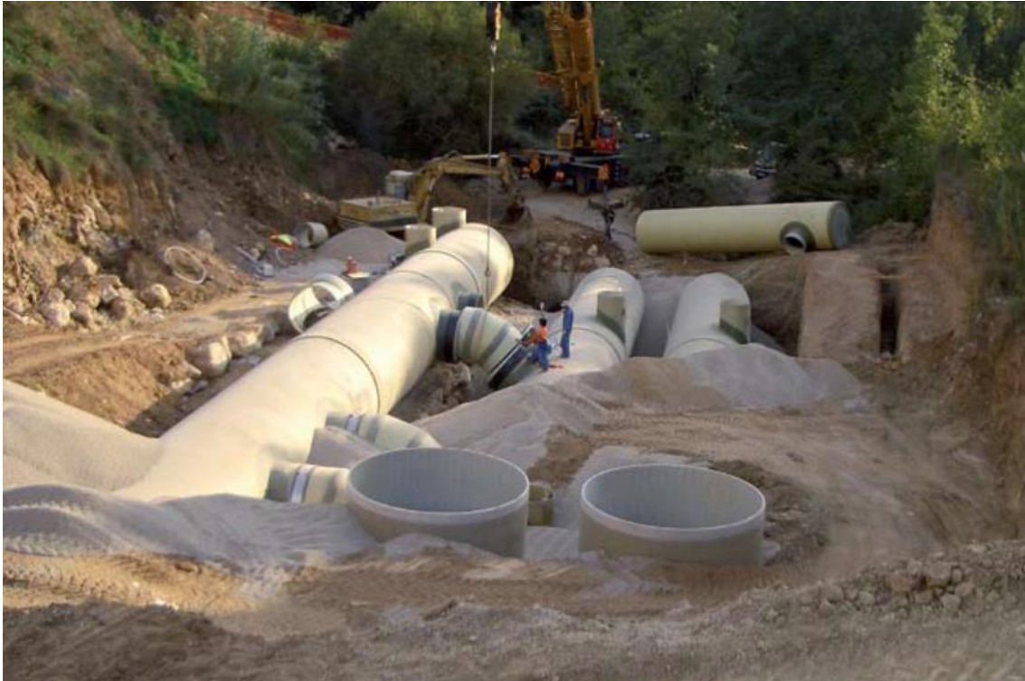
Montaje de un tanque de tormentas prefabricado de PRFV
