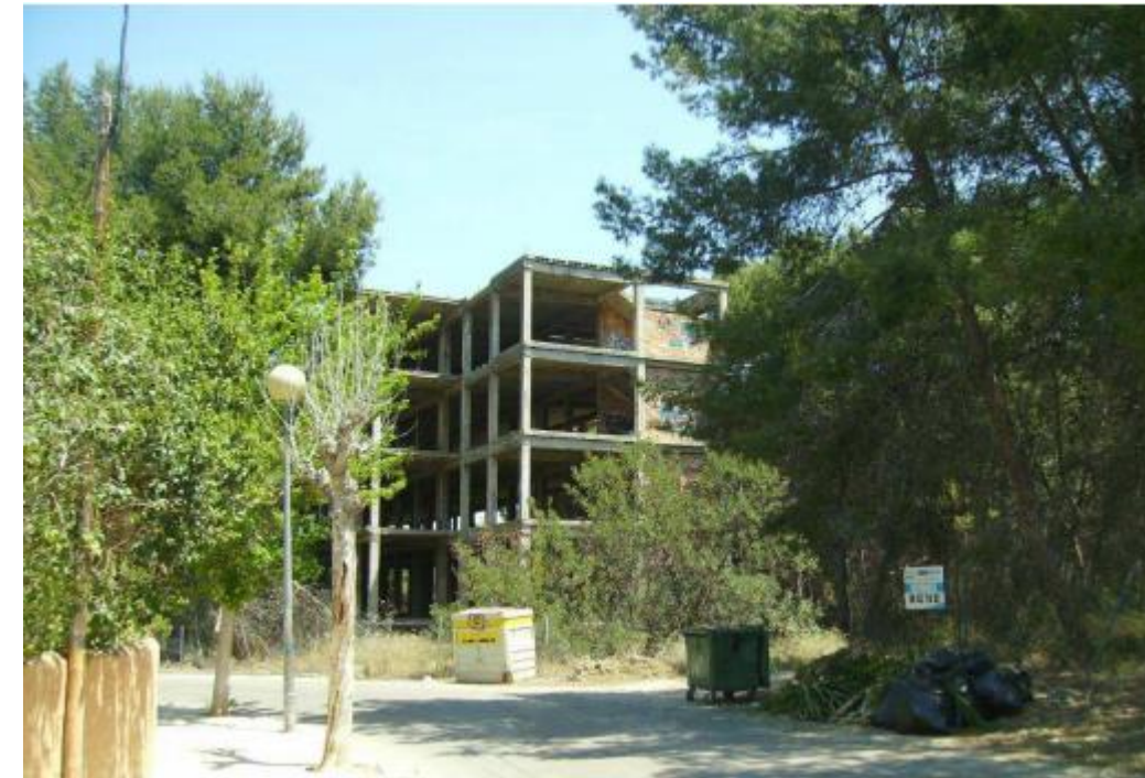
Figura 2.8. Vista desde la calle 292
