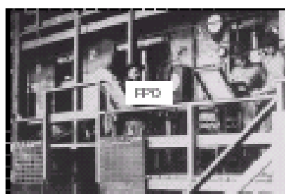
Relleno de proyectiles de 75-mm artillería con gas mostaza, vista interior, planta de agentes químicos de Edgewood Arsenal (EE.UU) (fotos de CBDCHRRT, Aberdeen Proving Ground, Md.)
