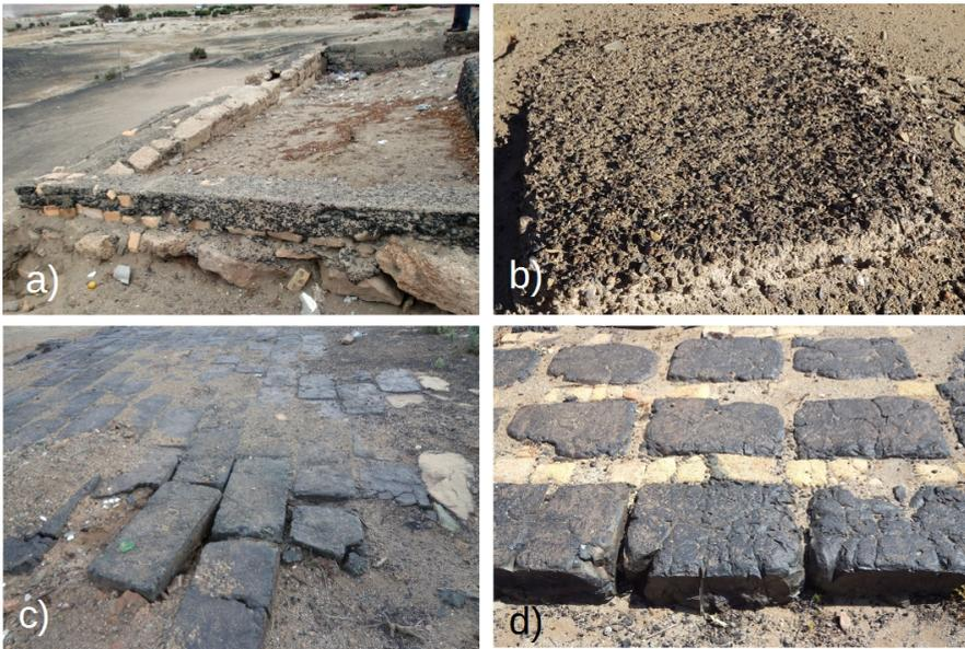
*Figura 2.12: Uso de escorias antiguas como árido en hormigones. a) y b). En pavimento: c) bloques de EC unidos por arena y d) bloques de EC con ladrillos refractarios.*
