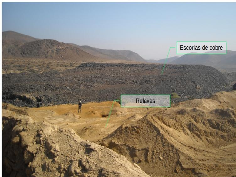
*Figura 2.7: Vertederos de residuos mineros: relaves hidrometalúrgicos y escorias de fundición de cobre. Canto del Agua, Atacama, Chile.*
