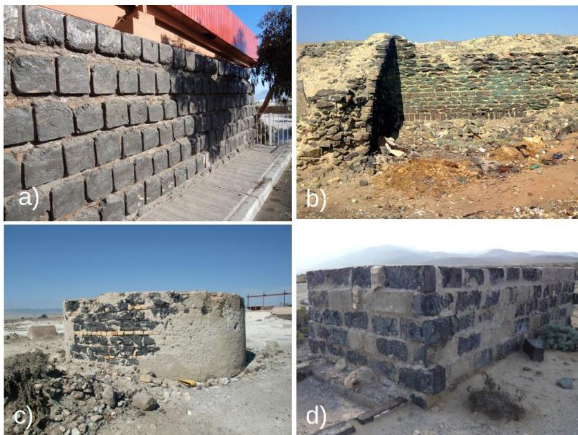
*Figura 2.13: Uso de escorias antiguas como mampuesto. a) Muro en la localidad de Chañaral, b) muro de contención en Carrizal Bajo, c) estanque de agua en Playa Negra, y d) estanque en Canto del Agua.*
