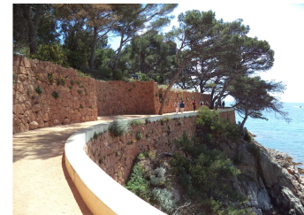
Camino de Ronda de S'Agaró. Castell-Platja d'Aro. RGA Arquitectes, 1999-2001.
