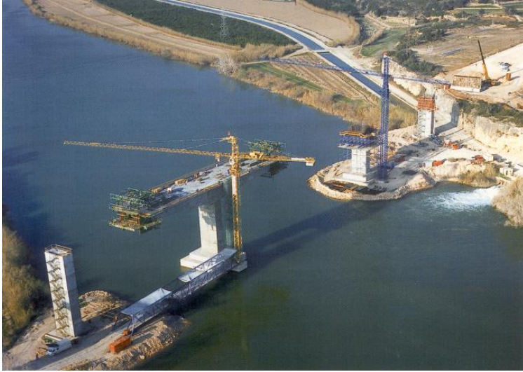
Figura 1.1. Construcción del puente sobre el Ebro en la línea del Corredor Mediterráneo, tramo Valencia-Tarragona.
