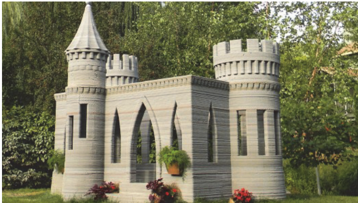
Figura 12.8. Castillo de hormigón impreso en 3D por Andy Rudenko
