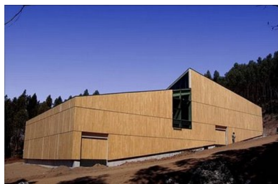
Bodegas Montepedroso. Rueda, Valladolid, 2012
