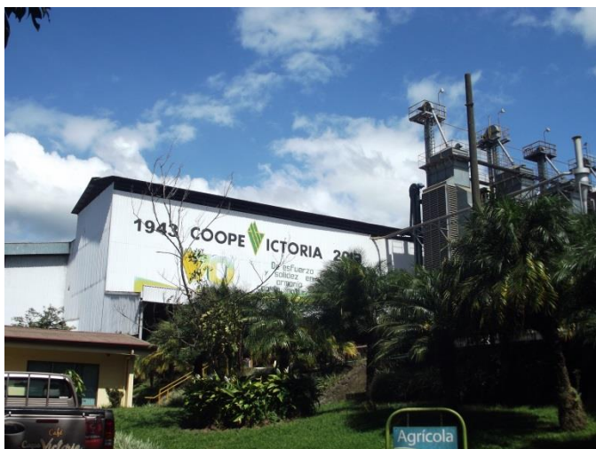
Figura 8: Instalaciones de CoopeVictoria
