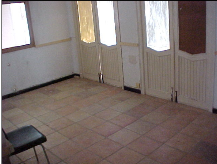
Figura 11. Estado de la Sala de Locución en Julio de 2003.
