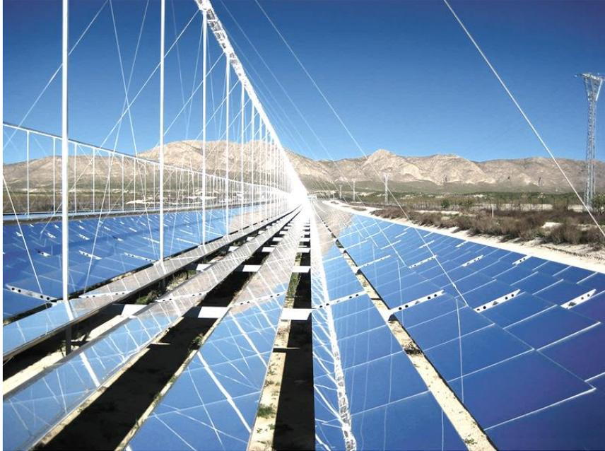
**Imagen 5. Captadores cilindroparabólicos de NSO 250 MW – Boulder City [Nevada, Estados Unidos]**
