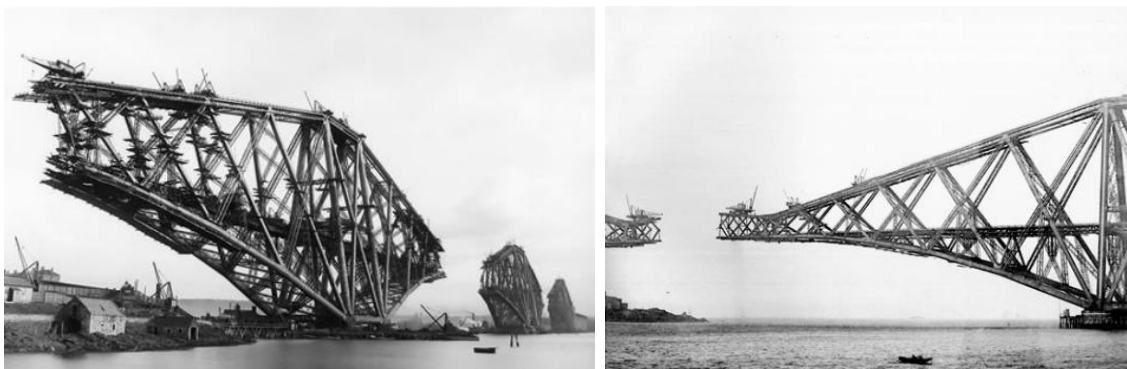
[Imagen 11. Construcción de los brazos.] [Imagen 12. Construcción del tramos suspendido.]
