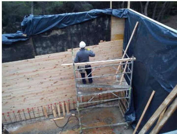
Otro aspecto importante son la elección de los paneles de encofrado pues ello define las juntas de hormigonado y los agujeros que se necesitan para los pasadores que anclan los paneles de encofrado. Los paneles escogidos son de 0,75 m x 2,70 m.
