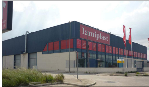
Figura 6: Nave Industrial "Lamiplast", Plg. Industrial Jovaes. Fuente: www.cons-just.com .
