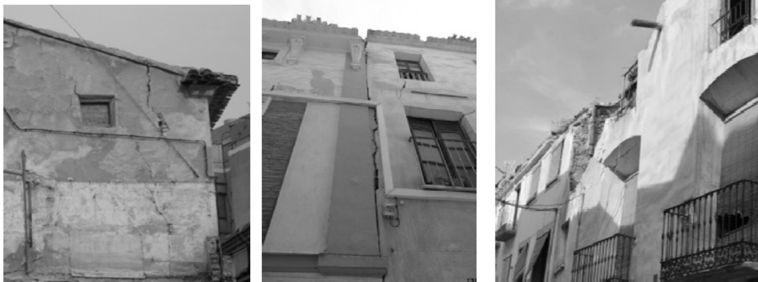
Figura 11. Lesiones producidas por acciones sísmicas (Lorca)
