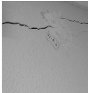
Figura 3. Testigos de yeso
