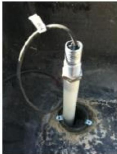
*Figura 5.3. Medidor de escorrentía en fase de instalación.*
