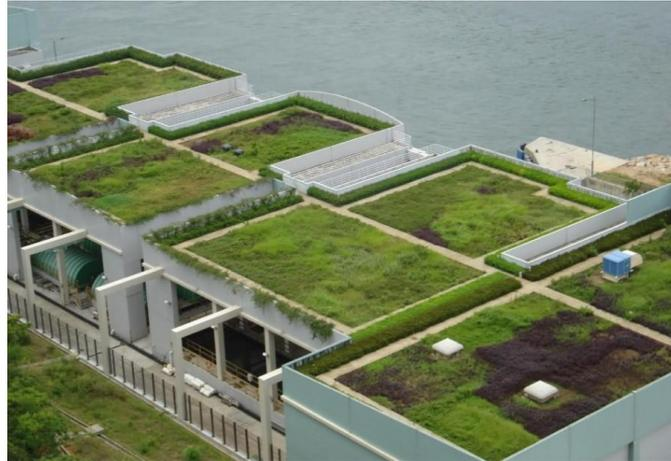
*Figura 3.5. Aspecto típico de un cubierta vegetada extensiva (www.greenroofs.com).*
