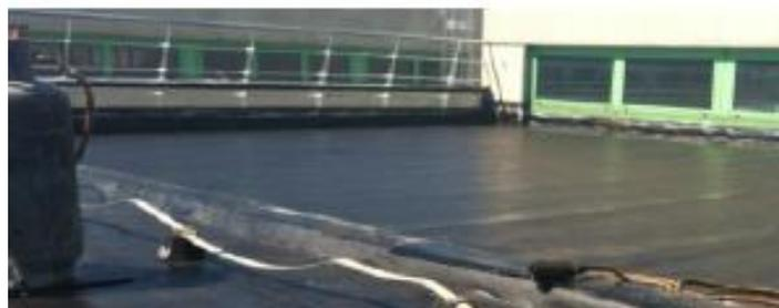
*Figura 4.8. Fase de instalación de la membrana sobre la superficie NR.*
