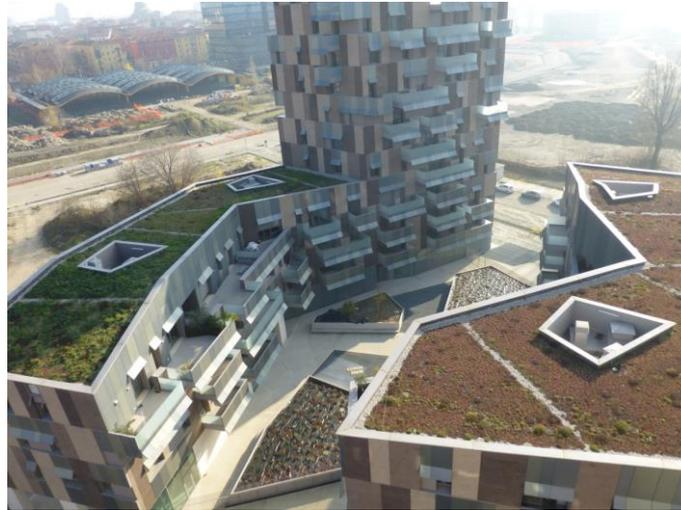
*Figura 9.5. Cubiertas vegetadas ya instaladas.*
