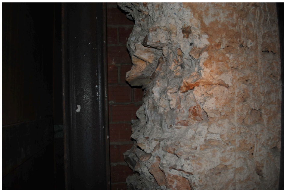
Figura 16. Muro exterior de mampostería y mortero de cal del Museo de Historia de Valencia (Fuente: Elaboración propia).
