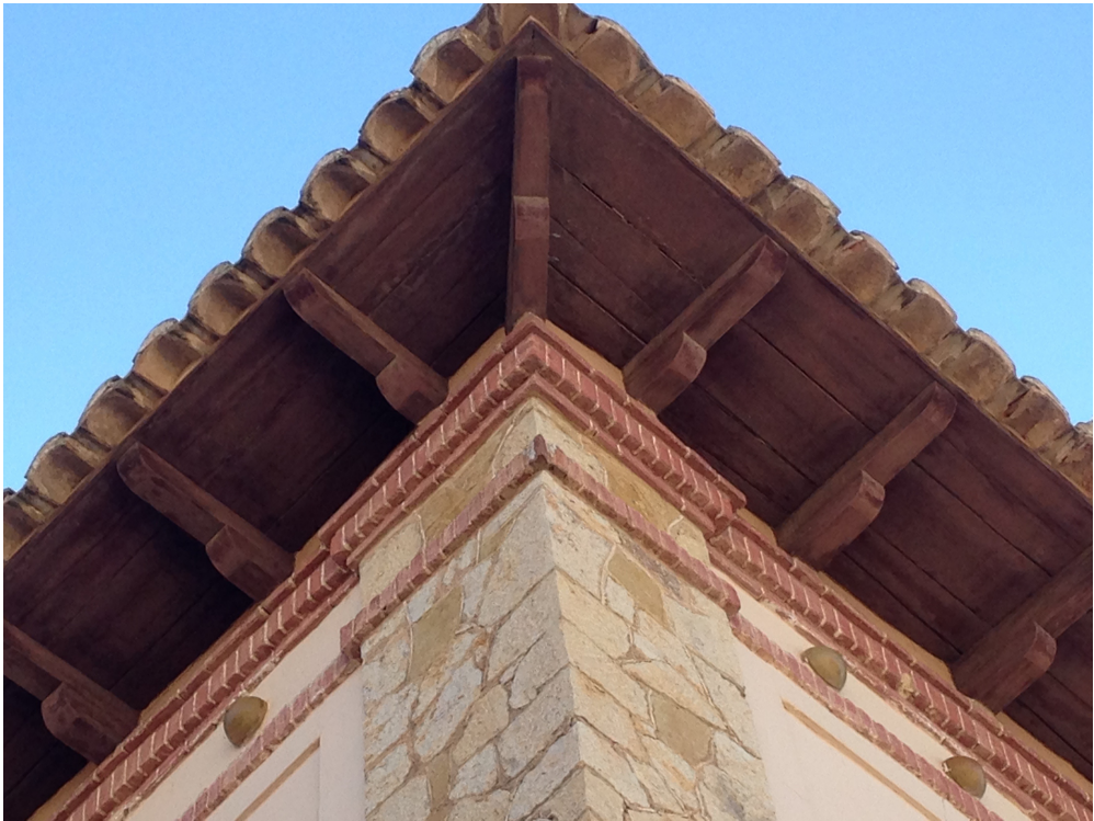
Figura 30. Detalle del encuentro entre aleros del C.E.I.P. Fabián y Fuero (Fuente: Elaboración propia).
