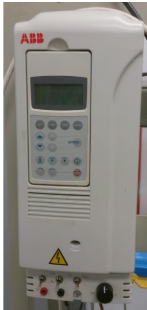
Figura 4.12 Variador de frecuencia marca ABB modelo ACS800-01-0005-3+E200+L502.
