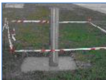
Imagen 56 - Zapata de hormigón
