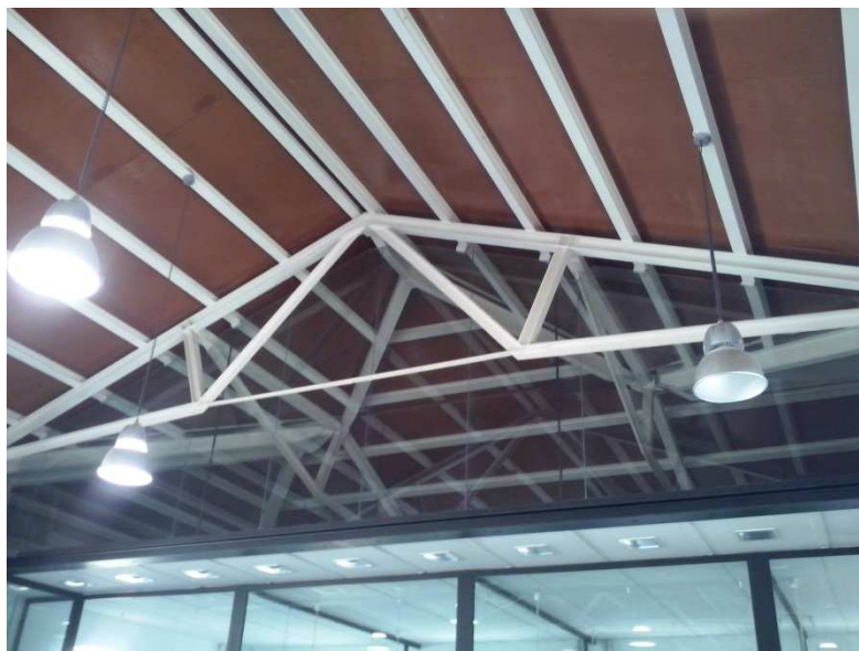
23-Cercha metálica de sustentación de cubierta. Fuente: propia.
