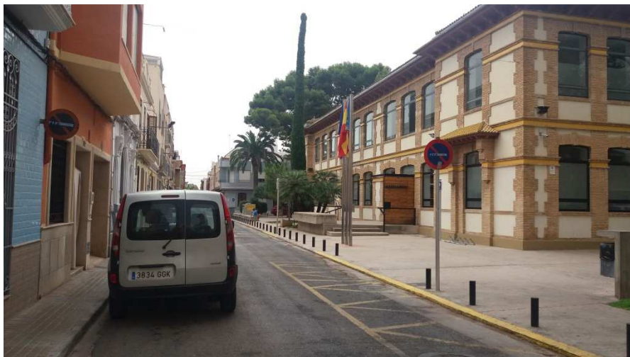
13-Fachada C/ Condes de Trigona. Fuente: propia.
