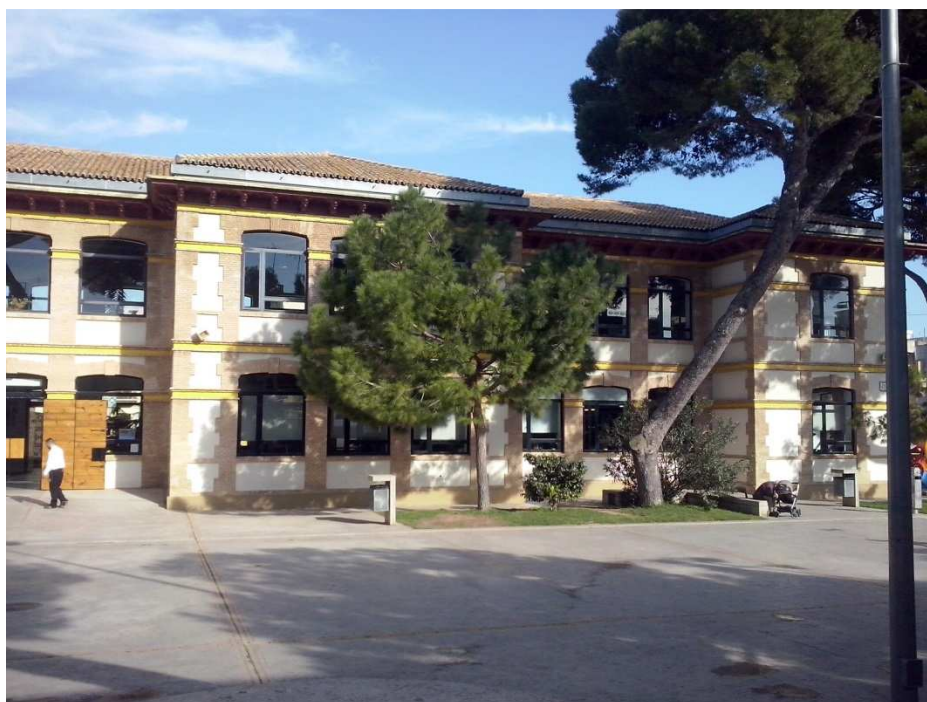
2-Exterior del ayuntamiento. Fuente: propia.
