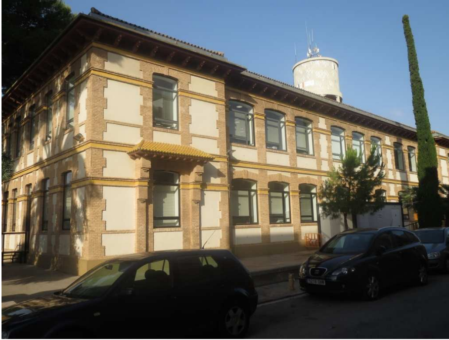
12-Fachada C/ Condes de Trigona. Fuente: propia.
