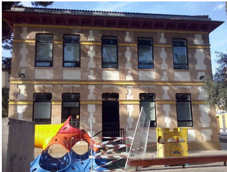
7-Fachada este por C/ L'Orba. Fuente: propia.
