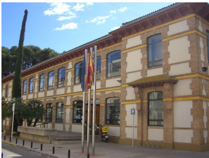
Imagen 1 EXTERIOR: Fachada entrada principal al edificio. Fuente: Cámara propia
