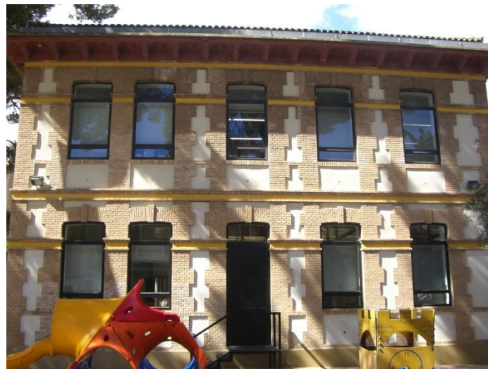
Imagen 7 EXTERIOR: Fachada con salida de emergencia. Fuente: Cámara propia
