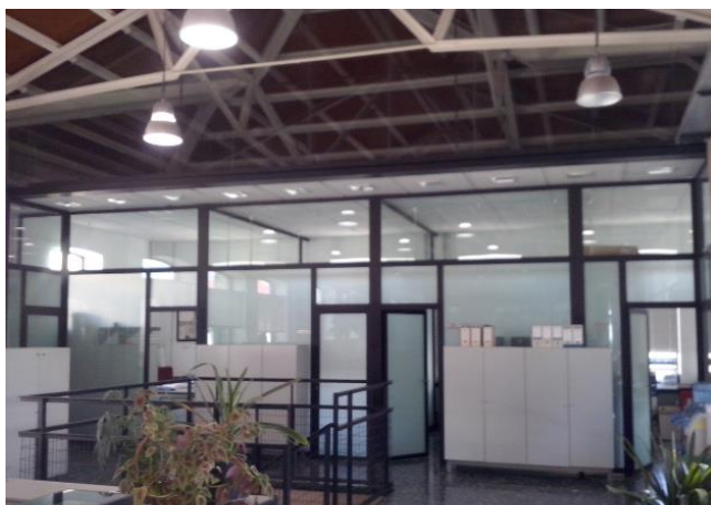
Imagen 5 MEMORIA CONSTRUCTIVA: Particiones elementos prefabricados. Fuente: Propia
