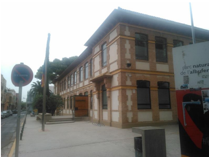
Imagen 2 EXTERIOR: Fachada entrada principal al edificio. Fuente: Cámara propia
