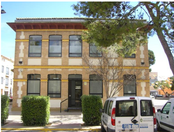
Imagen 5 EXTERIOR: Fachada entrada a la Policía Local. Fuente: Cámara propia
