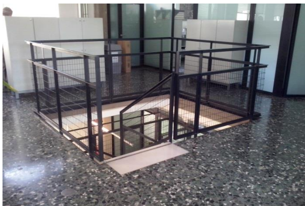
Imagen 11 MEMORIA CONSTRUCTIVA: Pavimento terrazo. Fuente: Propia
